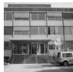
Abb. 2.: Haupteingang vor der Modernisierung
