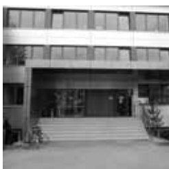
Abb. 5.: Haupteingang nach der Sanierung
