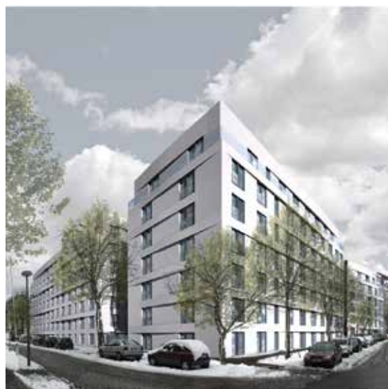
Abb. 1.: Ecke Flut- Fließstrasse
