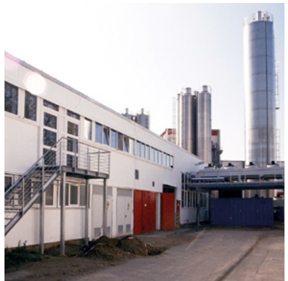
Ansicht der Halle
