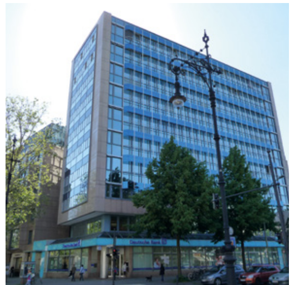
Fassade nach der Giebelöffnung
