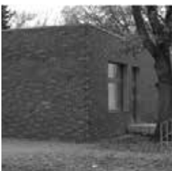
Abb. 3.: Neubau Hortgebäude, Haupteingang
