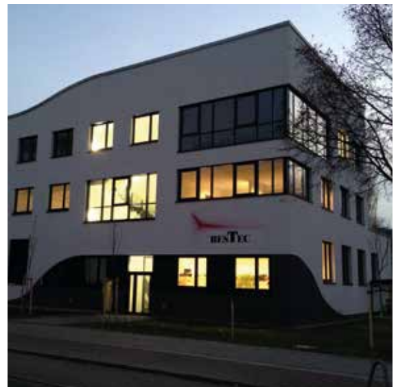
Erarbeitung eines ganzheitlichen Brandschutznachweises für die Niederlassungen der Firmen BESTEC und LTB
