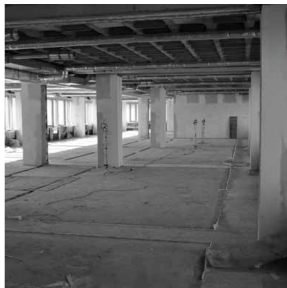
Abb. 2.: Entkerntes Geschoss vor der Sanierungsmaßnahme
