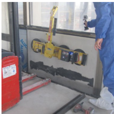
Ausstausch eines Fassadenelements
