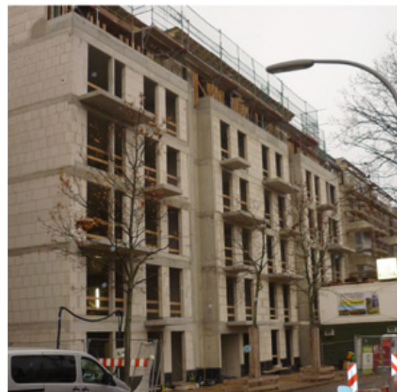
Ansicht nach Rohbaufertigstellung
